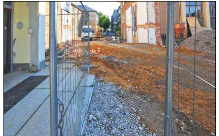
Eine ungewohnte Perspektive: Die bislang bebaute Fläche zwischen Schönfeld-Hörsaal und dem D-Flügel gibt nach dem Abriss des Verbindungsbaus jetzt den Blick bis zur Helmholtzstraße frei. Foto: UJ/Eckold
