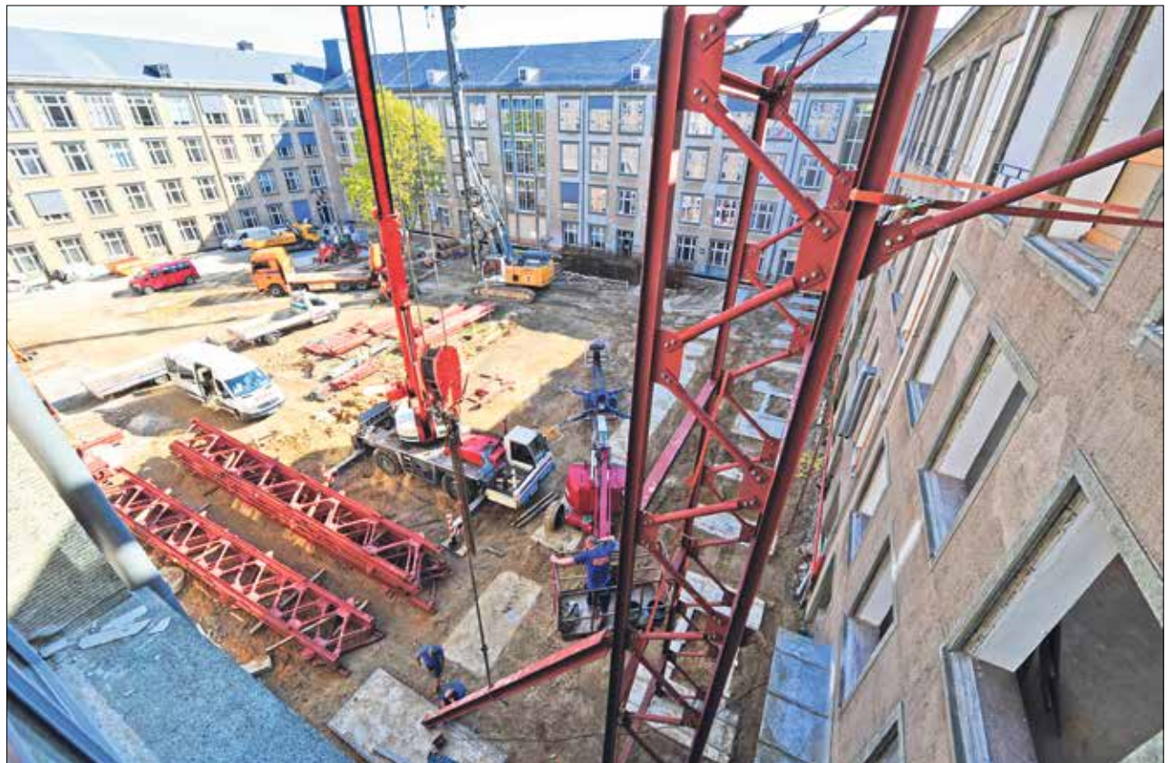
Im Innenhof des Barkhausen-Baus entsteht ein neues Laborgebäude für Nano-Analytik. Die Fassade des D-Flügels (r.) wird gesichert und erhalten. Das Gebäudeensemble Barkhausen-Bau wurde in mehreren Bauabschnitten von 1951 bis 1965 erbaut und steht unter Denkmalschutz. Foto: UJ/Eckold
